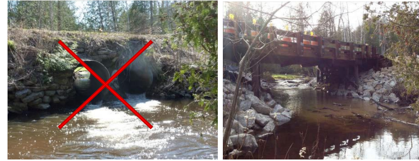
Utak vízfolyások feletti megfelelő átvezetése
